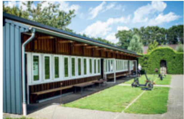
Die Schießhalle entstand in einer Bauzeit von nur drei Monaten. Foto: Günter Kuhr / Bogensport Magazin
